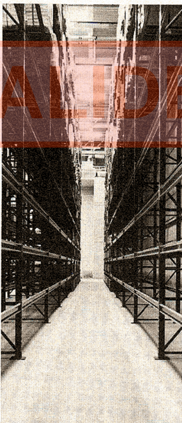
Fugenloser Industriebodenbelag im Mittelhochregallager der Armeeapotheke in Bern-Ittigen Revêtement de sol industriel sans joint dans la halle de stockage de la pharmacie de l'armée à Berne-Ittigen
