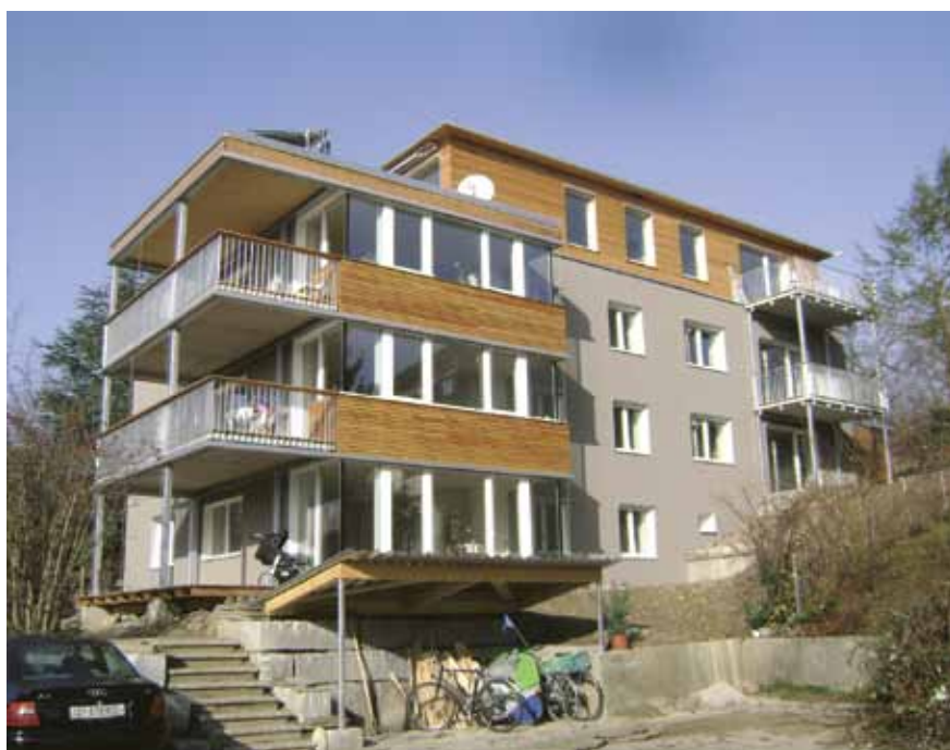
Abb. 39: Umbau Mehrfamilienhaus Segantinistrasse, Höngg
