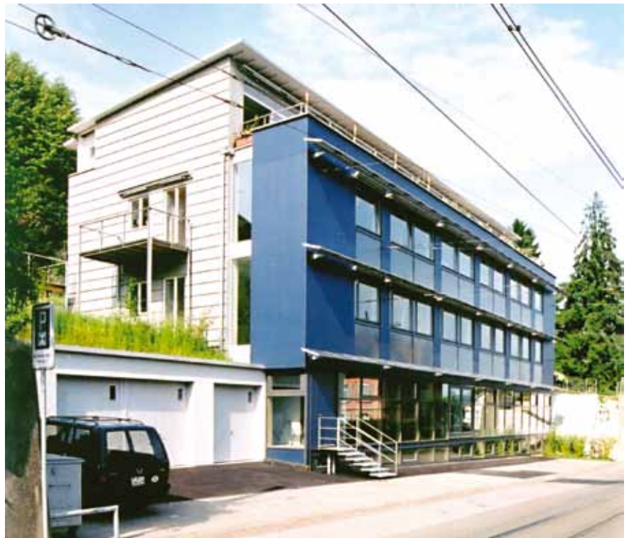
Abb. 16: Umbau Wohn- und Gewerbehäuser Limmattalstrasse, Zürich
