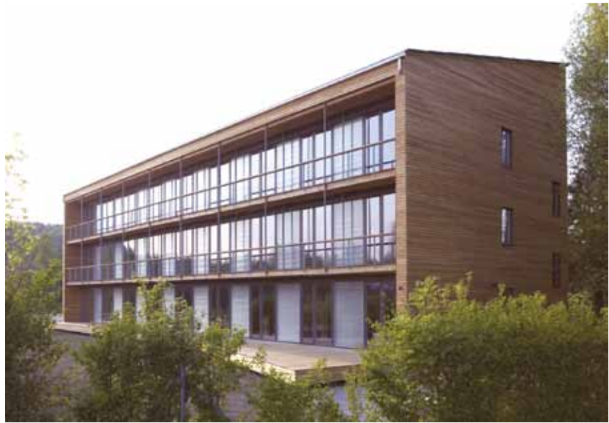
Abb. 15: Verwaltungsgebäude von Marché International in Kemptal
