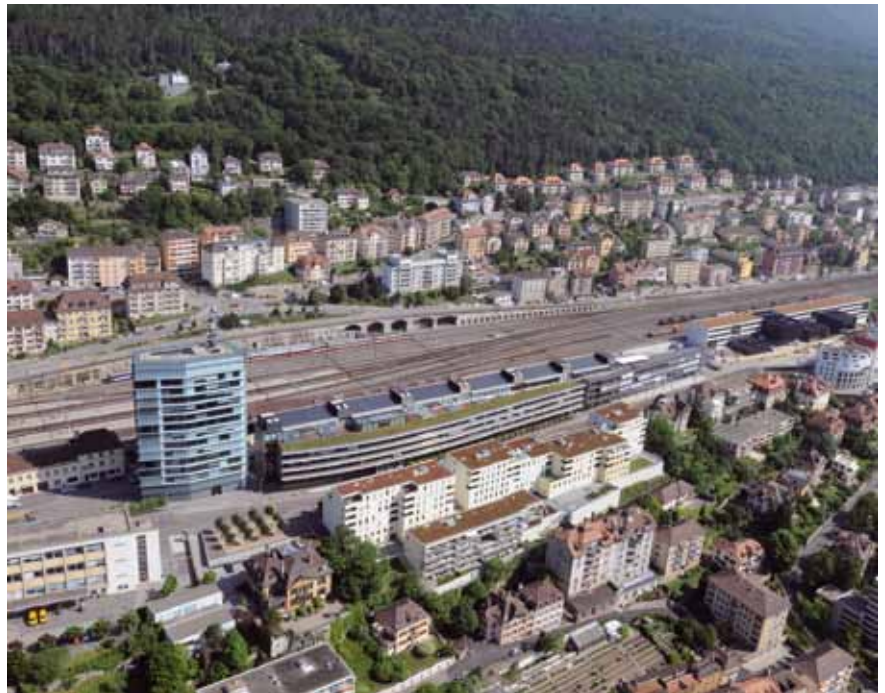
Abb. 18: Verwaltungsgebäude des Bundesamts für Statistik, Neuchâtel
