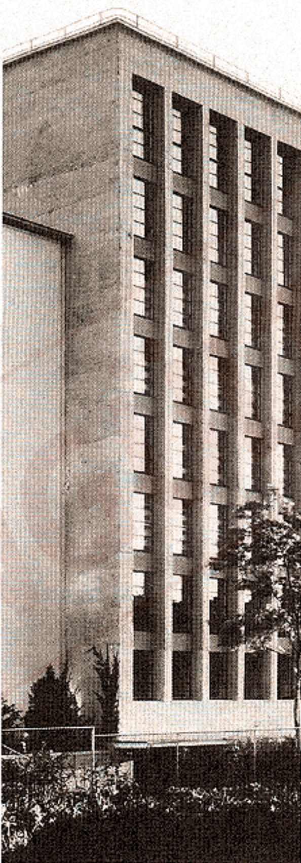
Schweizerische Landesbibliothek Bern, erbaut 1932, Sichtbetonfassade des Büchermagazins. Die Fassade wird 1997/98 erstmals saniert.
