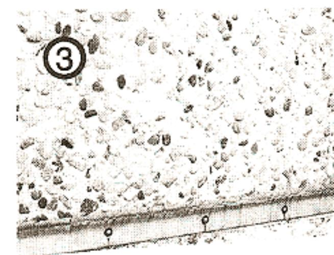
**Abb.3** Die Kontraktion der Bahn hat zum Losreissen der Aufbordung geführt. Sofortmassnahmen sind nötig.
