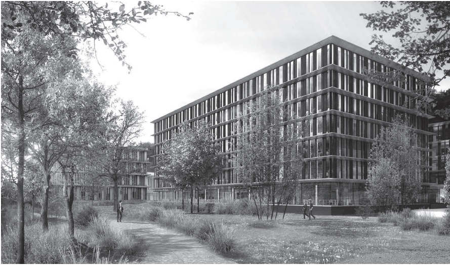
Neubau Bürogebäude Ittigen: Das Gebäude wurde in der Pilotphase nach dem Standard Nachhaltiges Bauen SNBS beurteilt.
