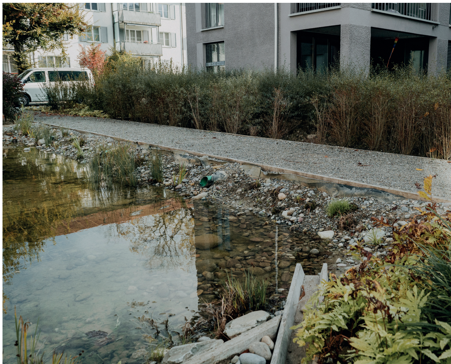
Figura 2: stagno di ritenzione integrato nella configurazione dello spazio con troppo pieno (tubo verde) che scarica l'acqua dall'altra parte del viottolo.
