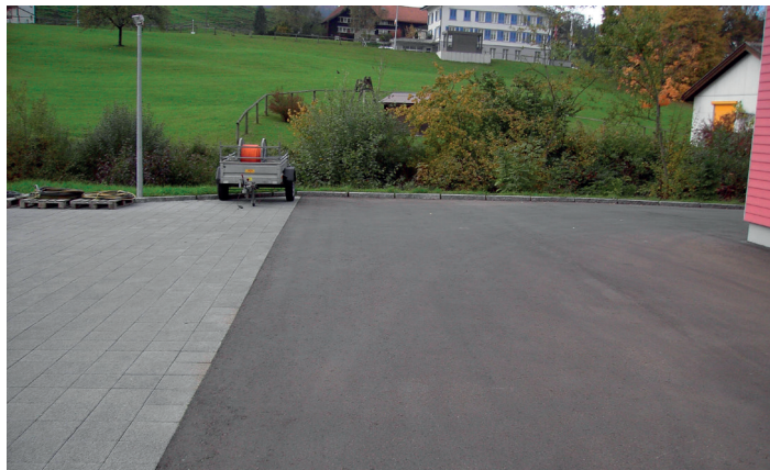
Figura 11: smaltimento «oltre il profilo» delle acque di un parcheggio. In caso di forti piogge, gli interstizi nei bordi del parcheggio (a destra) fungono da organo di strozzamento. Il parcheggio è temporaneamente chiuso.
