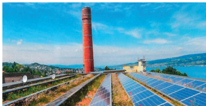
Figura 9: a sinistra un tetto ricoperto di vegetazione per la promozione della biodiversità. A destra la combinazione di un prato fiorito e di un impianto fotovoltaico. La ritenzione delle acque sul tetto offre soluzioni multifunzionali. Le acque meteoriche vengono provvisoriamente raccolte nel terreno del tetto e in parte deviate. La maggior parte dell'acqua viene utilizzata dalle piante o evapora.
