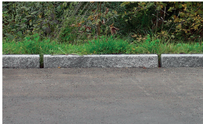
Figura 11: smaltimento «oltre il profilo» delle acque di un parcheggio. In caso di forti piogge, gli interstizi nei bordi del parcheggio (a destra) fungono da organo di strozzamento. Il parcheggio è temporaneamente chiuso.
