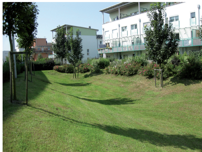
Figura 1: esempio di un bacino d'infiltrazione ben integrato nel quartiere
