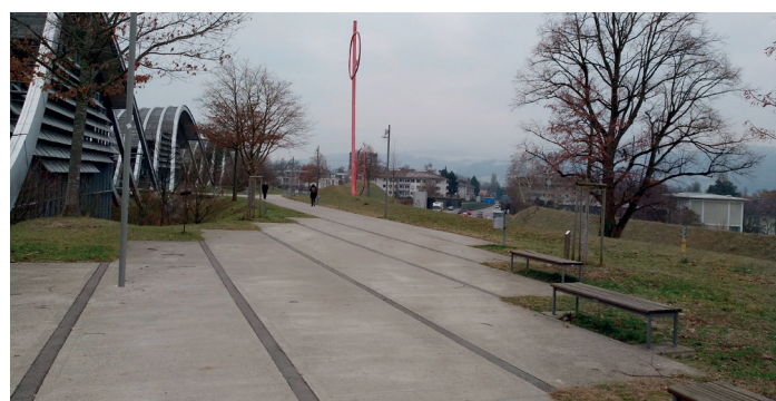
Figura 6: esempio d'infiltrazione «oltre il profilo» (a sinistra) e di una strada pedonale dalla quale le acque meteoriche vengono deviate su una striscia di prato, dove possono infiltrarsi su tutta la superficie.
