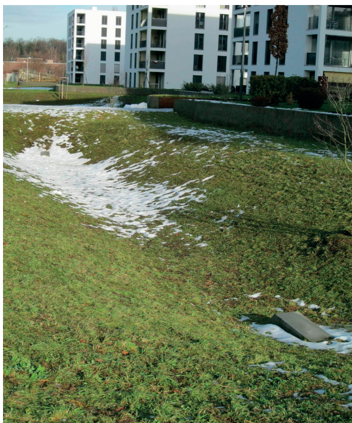
Figura 12: bacini di ritenzione e d'infiltrazione senza e con specchio d'acqua permanente.
