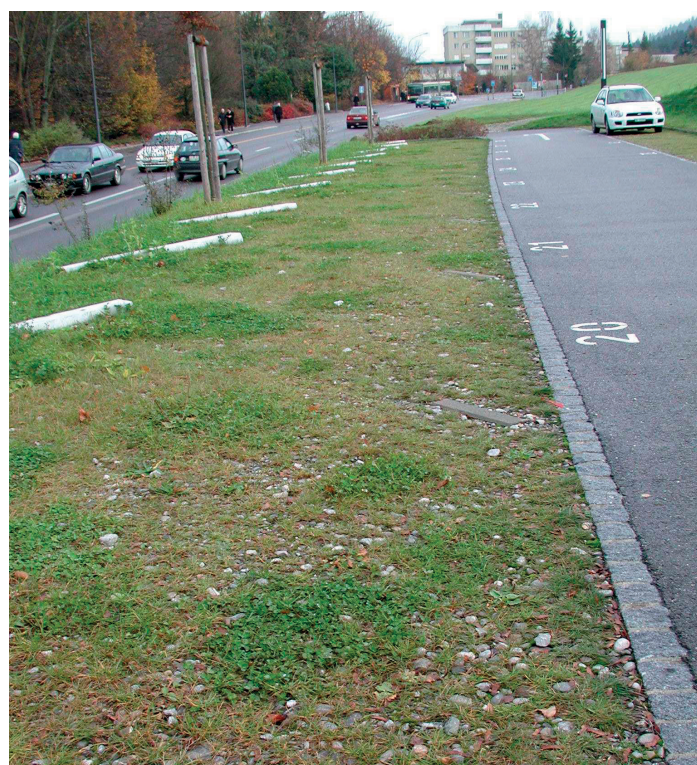
Figura 4: particolare della funzione di superfici e prati ghiaiosi (a sinistra); esempio di parcheggio su prato ghiaioso (a destra)
