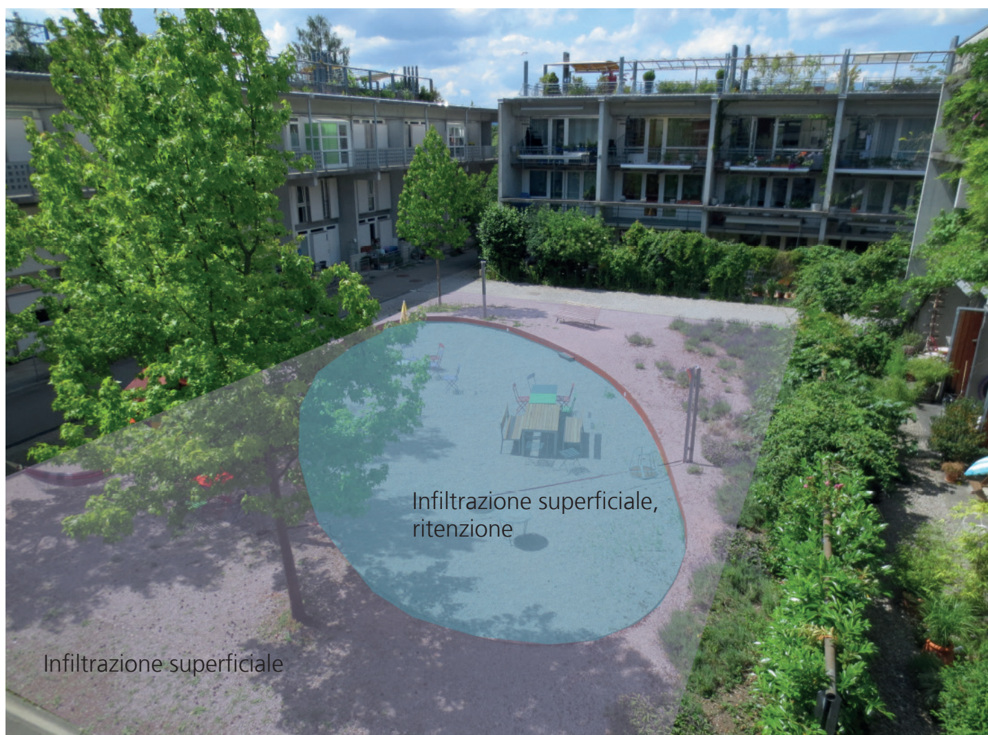
Figura 3: esempio di smaltimento delle acque di scarico ben integrato nella configurazione del quartiere. All'esterno è stato predisposto un prato ghiaioso (viola) e all'interno una superficie ghiaiosa (blu). In caso di forti piogge, quest'ultima funge da volume di ritenzione a breve termine.
