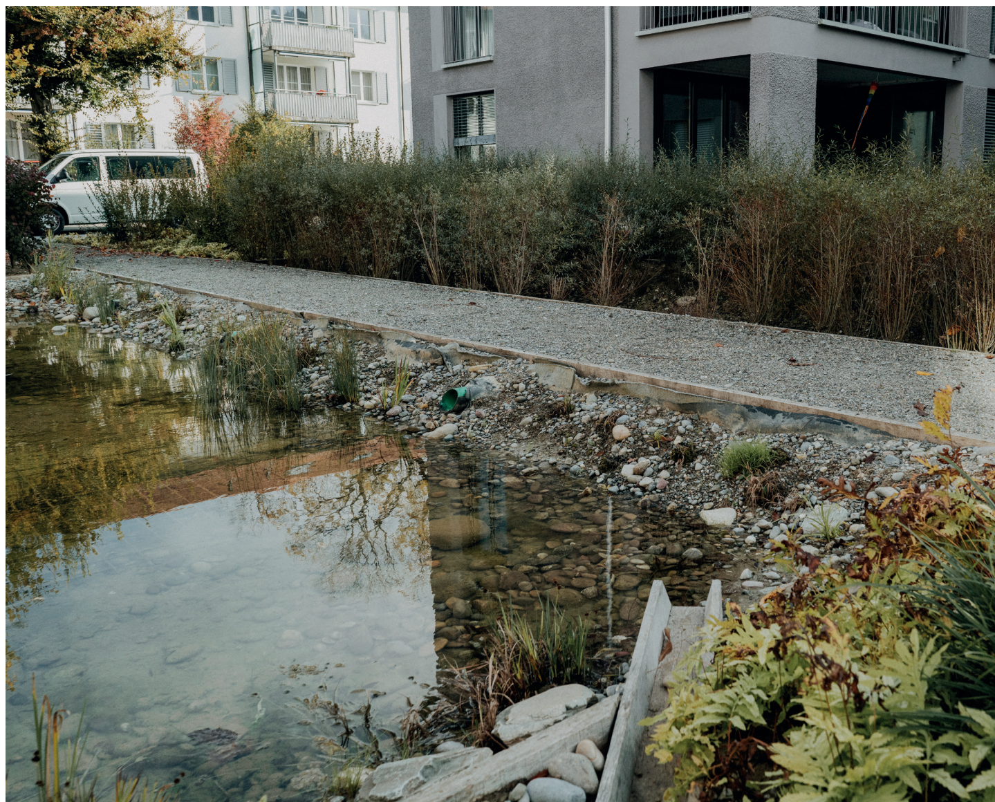
Illustration 2: Bassin de rétention intégré dans l'aménagement des abords avec déversoir (tuyau vert) donnant dans un bassin d'infiltration de l'autre côté du chemin
