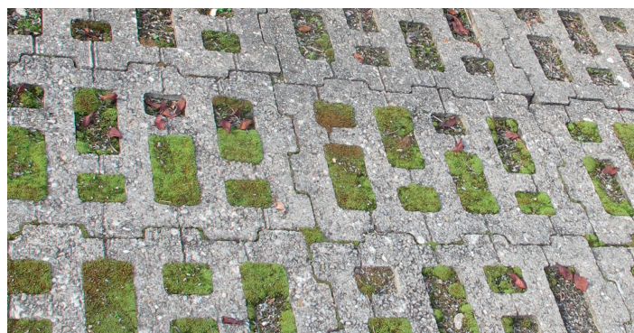
Illustration 5: Détail et photo de grilles-gazon (à gauche) et de pavés (à droite)
