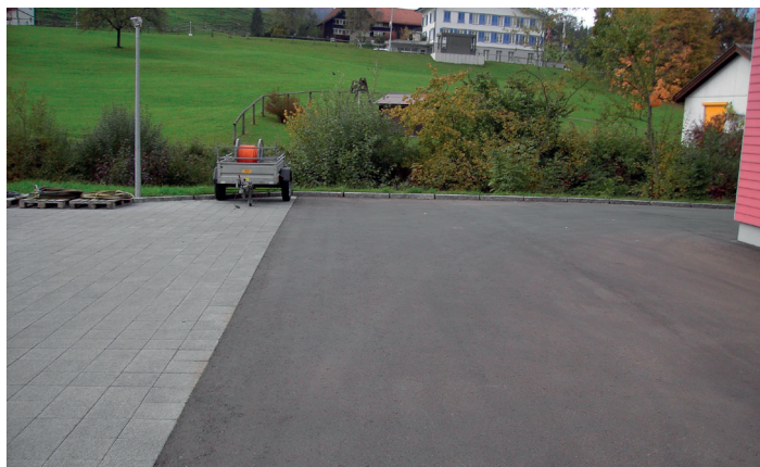
Illustration 11: Évacuation de l'eau d'un parking par les bas-côtés. En cas de fortes pluies, les interstices entre les bordures en béton (à droite) font office d'organe de limitation des débits. Le parking est temporairement submergé.
