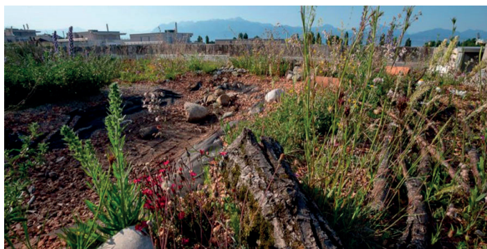
Illustration 9: Toit végétalisé favorisant la biodiversité (à gauche), combinaison d'un champ de fleurs et d'une installation photovoltaïque (à droite) La rétention sur les toits offre des solutions multifonctionnelles. Les eaux pluviales sont stockées temporairement dans le sol du toit végétalisé et évacuées partiellement. La majeure partie est absorbée par les plantes ou évaporée.
