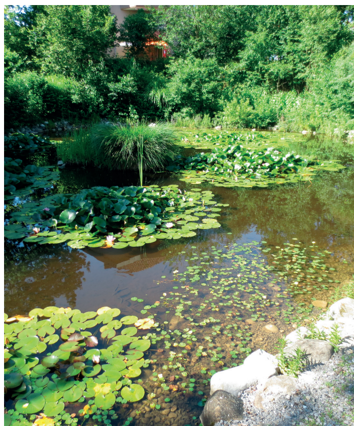
Illustration 12: Bassin de rétention et d'infiltration. Un secteur du bassin d'infiltration peut être totalement imperméabilisé et aménagé en biotope, voir exemple à droite.
