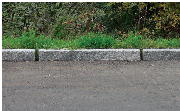
Illustration 11: Évacuation de l'eau d'un parking par les bas-côtés. En cas de fortes pluies, les interstices entre les bordures en béton (à droite) font office d'organe de limitation des débits. Le parking est temporairement submergé.
