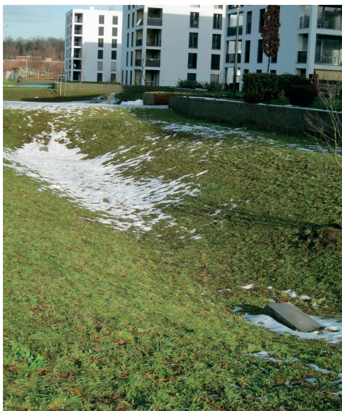
Illustration 12: Bassin de rétention et d'infiltration. Un secteur du bassin d'infiltration peut être totalement imperméabilisé et aménagé en biotope, voir exemple à droite.
