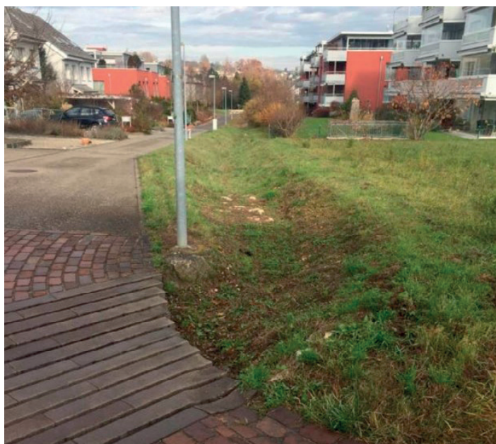
Illustration 10: Exemples de fossés qui retiennent les eaux pluviales en vue de leur infiltration sur place. À gauche: fossé le long d'une rue résidentielle; à droite: petit fossé aménagé pour l'infiltration des eaux de toiture d'une propriété.
