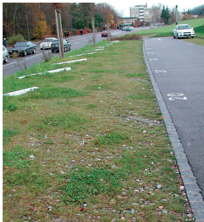
Illustration 4: Détail de la fonction du gazon-gravier et des bancs de gravier (à gauche); exemple d'une place de stationnement à base de gazon-gravier (à droite)
