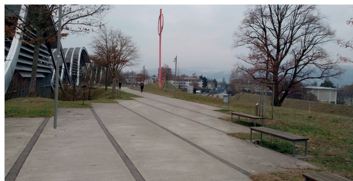
Illustration 6: Détail de l'infiltration dans les bas-côtés (à gauche) et d'un chemin piétonnier depuis lequel les eaux pluviales sont déversées dans une bande de gazon, où elles peuvent s'infiltrer en surface (à droite).
