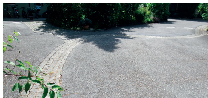
Illustration 8: Gouttière affleurant la surface: les eaux de toiture sont acheminées en surface jusqu'au site d'infiltration (à gauche). Exemples de caniveaux dans lesquels l'eau qui s'écoule en surface est utilisée pour l'aménagement des abords (à droite)
