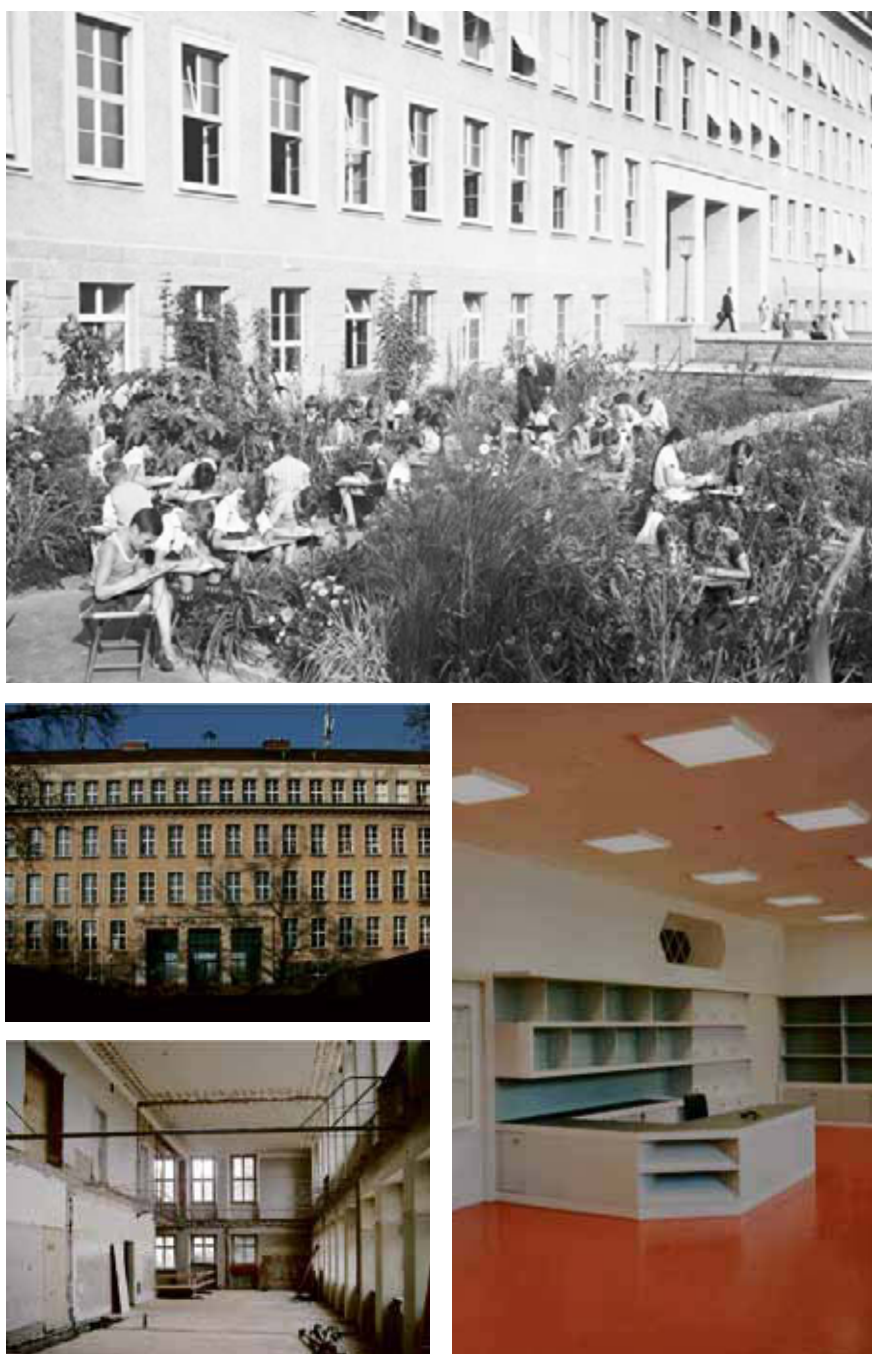
Fig. 31: Bâtiment scolaire Milchbuck, Zurich
