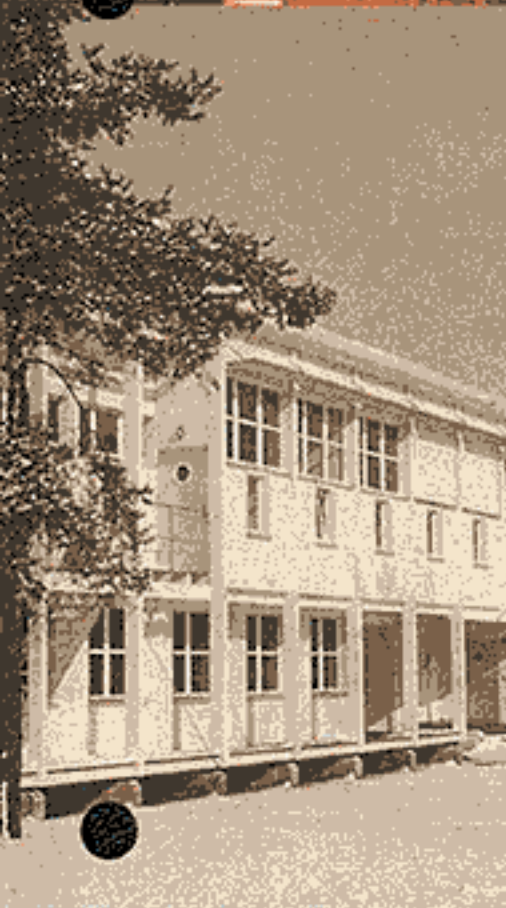
Bois Pavillon d'architecture EPF Zurich
