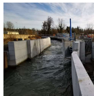
Tragfester Beton aus EOS-Granulat vom Stahlrecycling für den Ausbau der erneuerbaren Energieproduktion mit Wasserkraft
