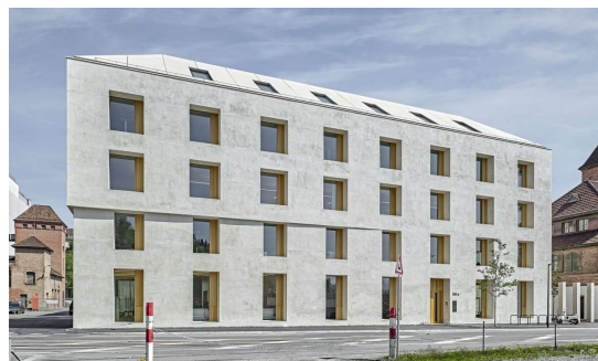
Bürohaus in Emmen «2226»
