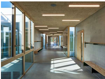
Beton mit RC-Gesteinskörnungen im Schulhaus Gebenstorf
